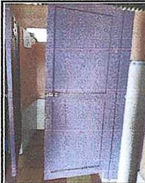
Foto 2: FOTOGRAFIA PUERTAS A SUSTITUIR
