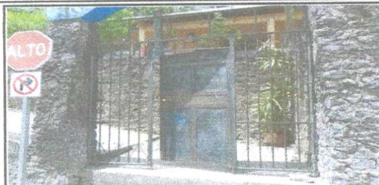
Foto 2: FOTOGRAFIA MANTENIMIENTO PORTON 1
