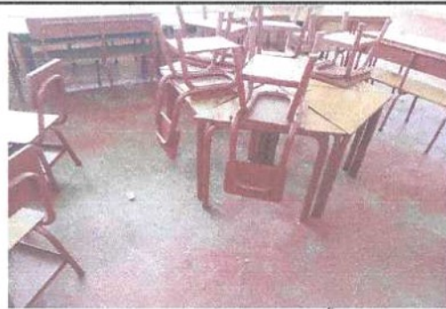
Foto 6: FOTOGRAFIA DE PISO A SUSTITUIR
