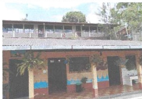
Foto 4: FOTOGRAFIA DE LAMINA Y ESTRUCTURA A SUSTITUIR
