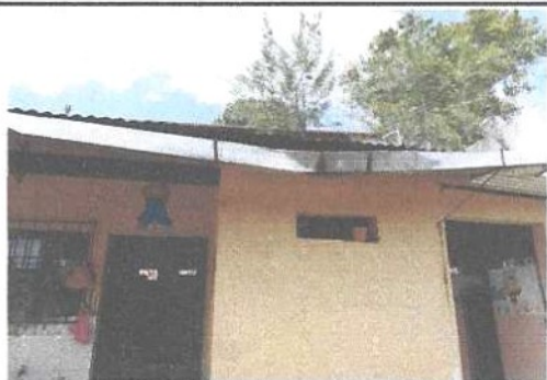
Foto 5: FOTOGRAFIA CANALES A SUSTITUIR
