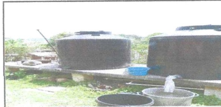
Foto 4: FOTOGRAFIA MANTENIMIENTO TINACOS
